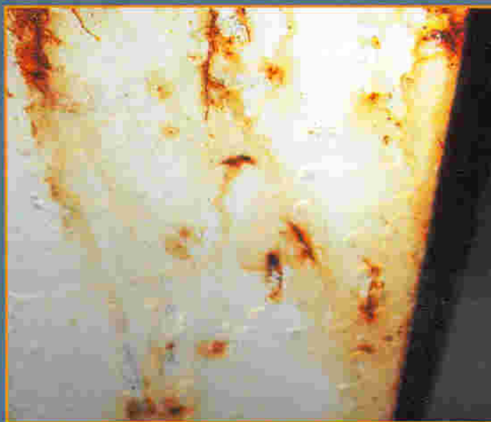
Рис. 2. Поверхность оцинкованного окрашенного профиля подконструкции НФС
