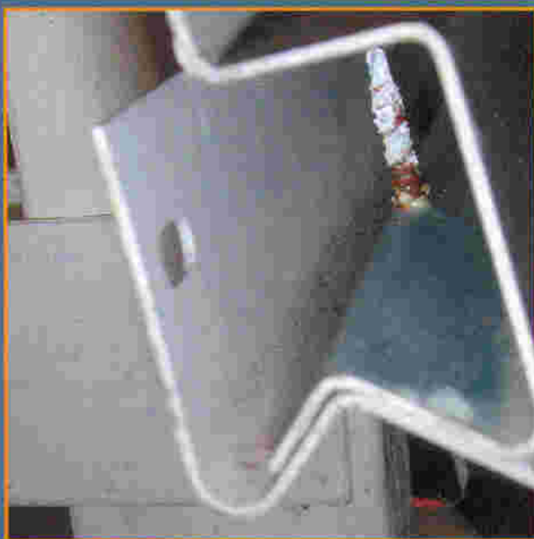
Рис. 1. Коррозионное повреждение «самореза» крепления облицовки НФС
