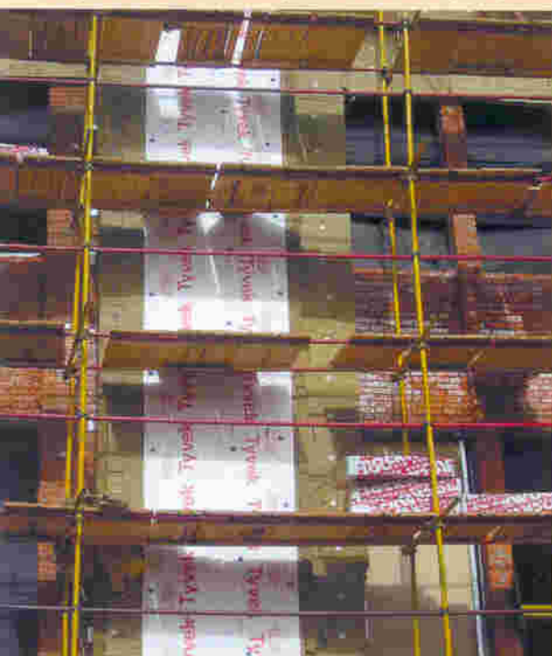
Рис. 10. Нарушена последовательность монтажа плит утеплителя. Сначала был установлен утеплитель (и кронштейны), затем выставлен витраж
