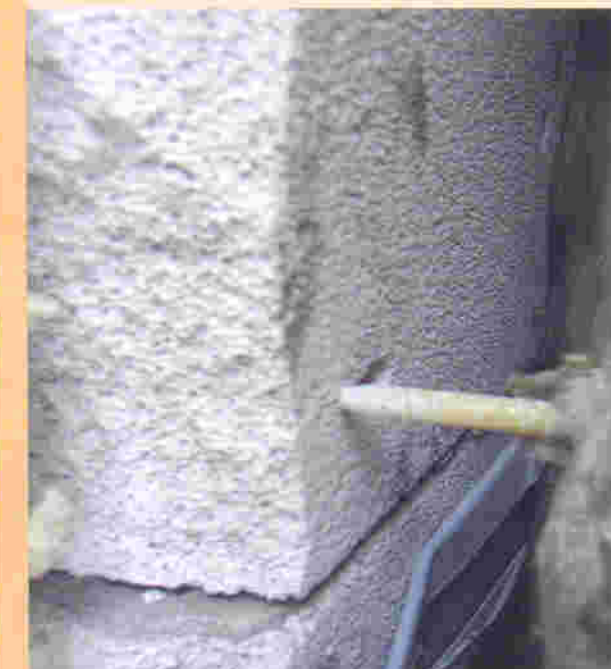
Рис. 7. Стержень тарельчатого дюбеля забит прямо в низкопрочный пенобетонный блок без использования гильзы
