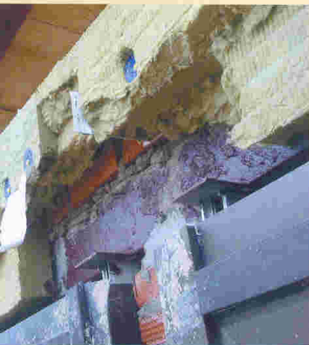
Рис. 12. Нарушена последовательность. Был установлен утеплитель, затем выставлен витраж, вырезан кусок минплиты и закреплена верхняя опора витража
