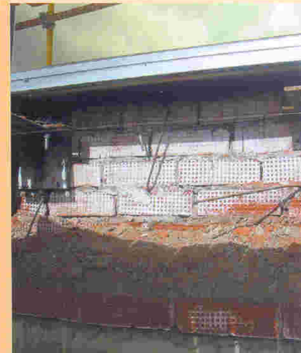
Рис. 4. Опорные консоли витражной конструкции создают мощные мостики холода. Результат выноса витражей за плоскость стены-основания наружу
