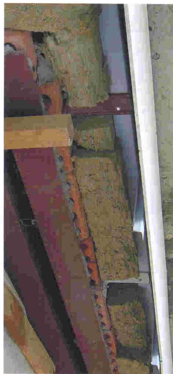
Рис. 6. Надоконная зона запроектирована таким образом, что возникли трудности с креплением утеплителя, а в дальнейшем и с герметизацией монтажного стыка по верху оконного блока
