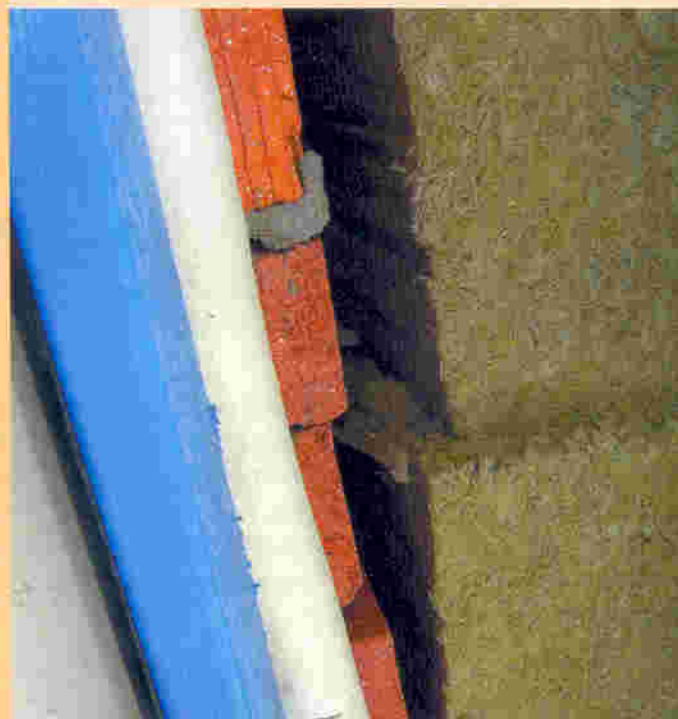
Рис. 16. Отсутствие самостоятельного дюбелирования первого слоя утеплителя привело к образованию второго вентилируемого зазора, прилегающего к стене-основанию
