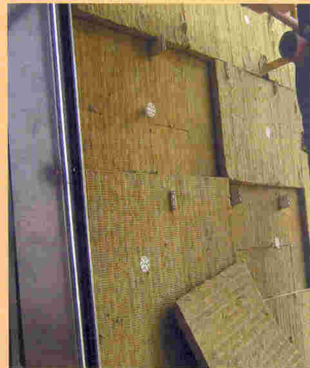
Рис. 15. Отсутствие самостоятельного дюбелирования первого слоя утеплителя создает возможности для образования сообщающихся пустот
