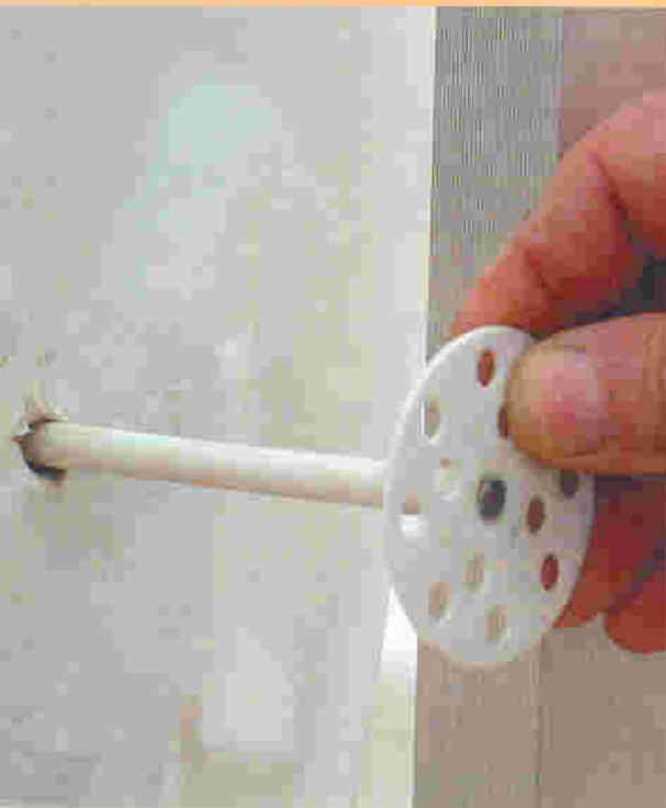
Рис. 8. Недостаточная длина дюбеля позволяет легко извлечь его из слоя утеплителя (утеплитель укрыт ветрогидрозащитной мембраной белого цвета)
