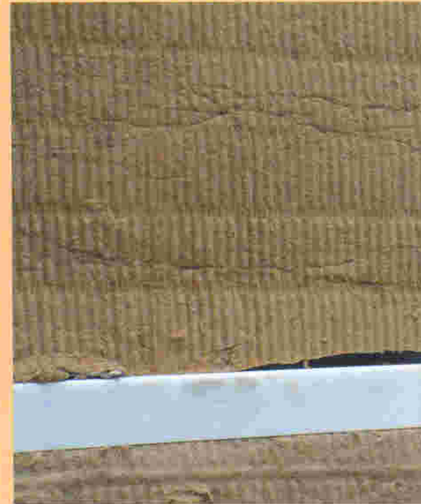
Рис. 2. Фронтальный вид того же узла, в котором направляющая используется для фиксации утеплителя в ущерб теплозащитным качествам
