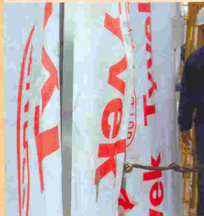
Рис. 3. Плоскость утепления совпадает с плоскостью наружных граней направляющих, предназначенных для установки облицовки. Вентилируемый воздушный зазор будет перекрыт
