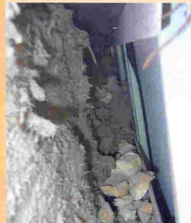
Рис. 17. Вентилируемый воздушный зазор (между утеплителем и облицовкой) засыпан строительным мусором
