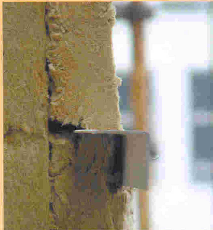
Рис. 1. Неверное с теплотехнической точки зрения расположение направляющей в поверхностном слое утеплителя создает условия для развития процесса коррозии в металлических элементах каркаса
