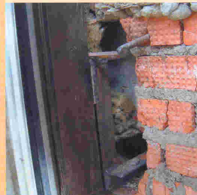
Рис. 5. Вынесенная наружу витражная конструкция создает существенные трудности по герметизации монтажного узла «сопряжения» оконного заполнения и утеплителя
