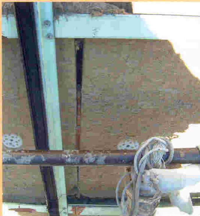
Рис. 14. Адгезия монтажной пены и минеральной плиты полностью нарушена, идет деструкция монтажной пены. Межплиточный шов открыт для проникновения холодного воздуха
