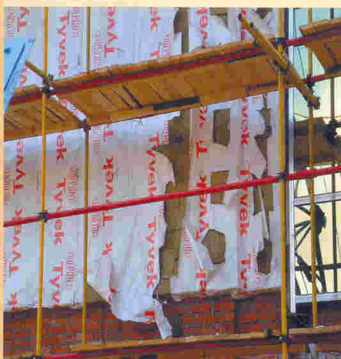
Рис. 11. Из-за неоднократной перестановки кронштейнов вслед за изменениями положения оконного витража нарушена сплошность утепляющего слоя (плиты утеплителя разрезаны на мелкие куски).
