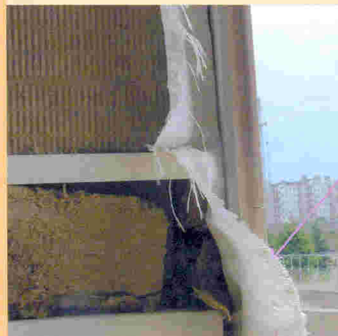
Рис. 19. Ошибочно примененная в качестве ветрогидрозащитной мембраны стеклоткань расположена поверх направляющих. Созданы условия для перекрытия воздушного зазора
