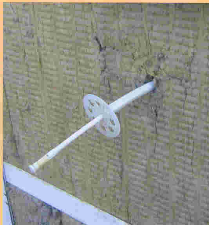
Рис. 9. Причина изгиба дюбеля – применение распорного элемента из мягкого пластика
