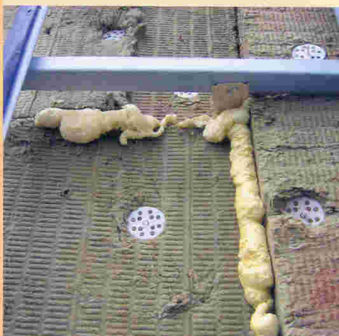
Рис. 13. Швы между соседними плитами заделаны монтажной пеной, которая через два года потеряет сцепление с минеральной ватой
