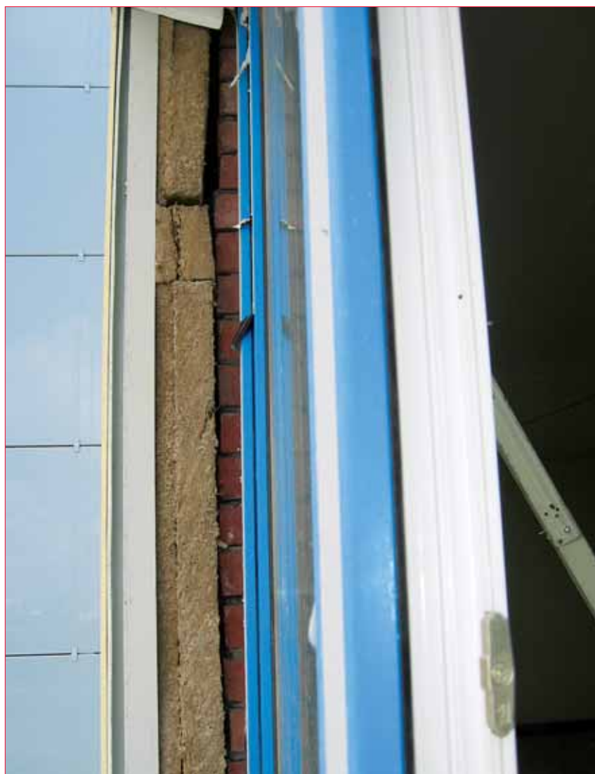
■ Рис. 7. Неплотное прилегание минераловатных плит к стене в межоконном простенке
