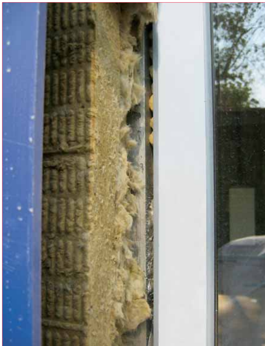
■ Рис. 9. Пример неправильного монтажа утеплителя. Минераловатные плиты не закрывают оконную коробку
